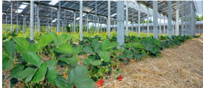
Agri-PV mit Doppelnutzung für Pflanzenbau und Tierhaltung
